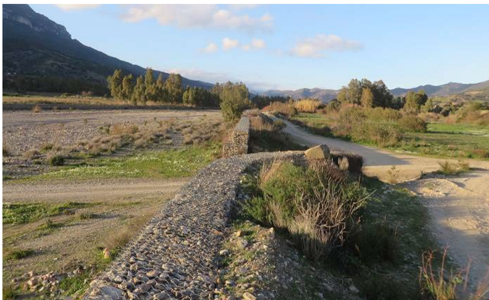
Figura 45 – Varco in corrispondenza di un guado. Si noti come la viabilità locale sia circa alla medesima quota del fondo alveo.
